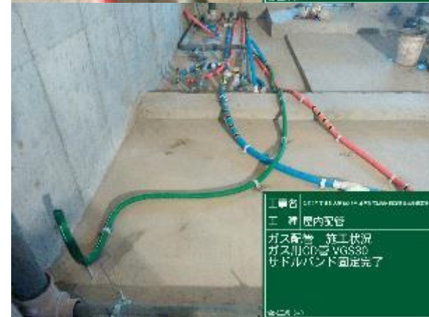
工種名 二 種 屋内配管 給水・給湯配管 施工状況 配管ポリエチレン管 サドルバンド固定
